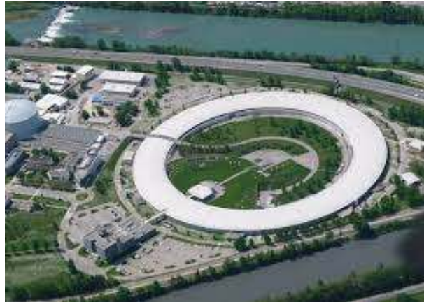
Figure 3: L’anneau du synchrotron de l’ESRF à Grenoble.
