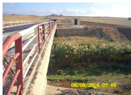
Figure 14. Station 2 A l'amont du barrage de foug elkhanga (Oued Sedrata).
