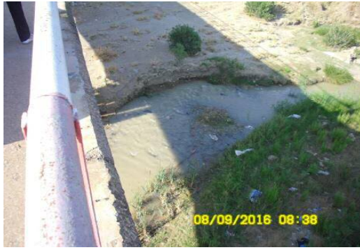
Figure 15. Station 3: A l'aval du Barrage de foug elkhanga.
