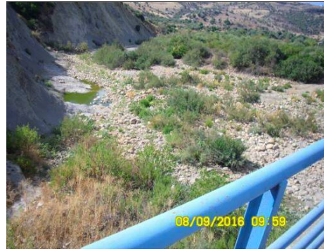
Figure 16. Station 4 : A l'amont du barrage de Bouhamdane.
