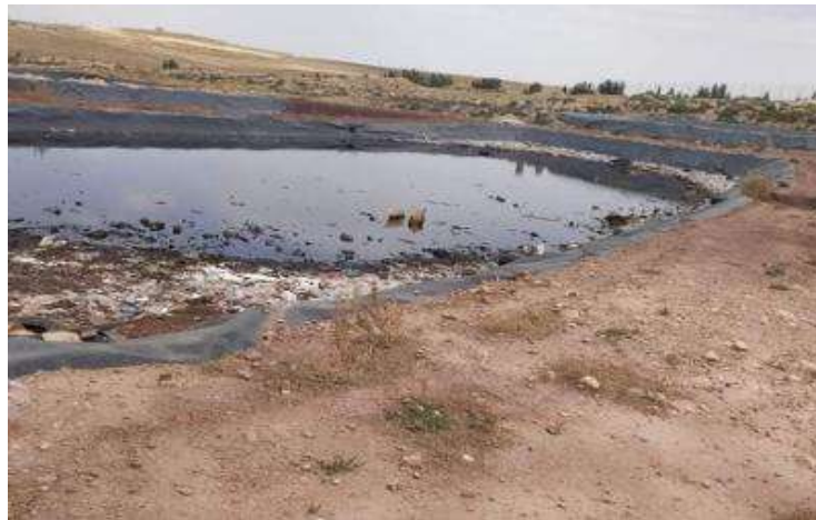
Figure 4 : Bassin de décantation des lixiviats
