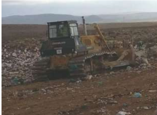
Figure 2 : Déchets déversés et assemblés dans des alvéoles
