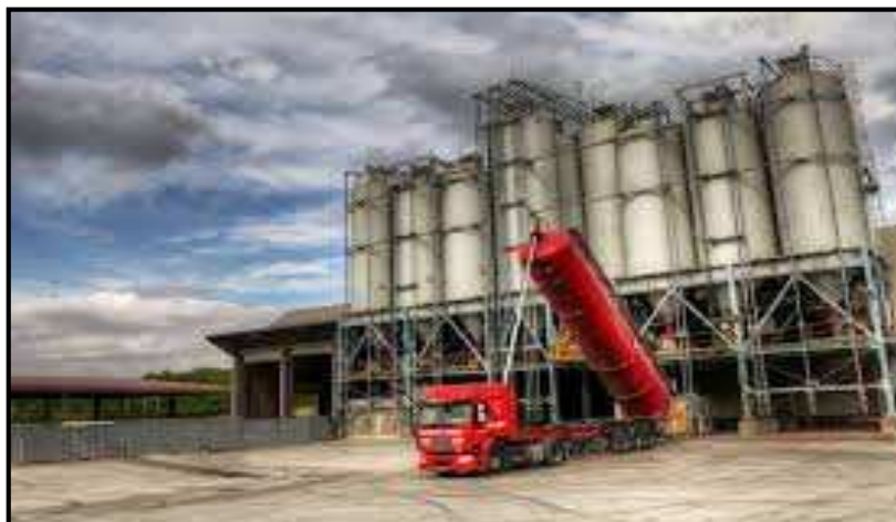
Figure III.8. Station de traitement de l'amiante [29].
