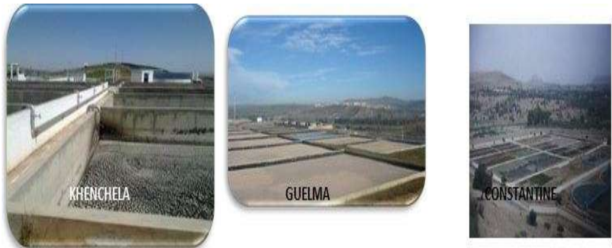
Figure 15 : déshydratation des boues des 3 stations
