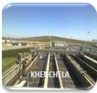
Figure 9 : Bassin Déshuileur des 2 station
