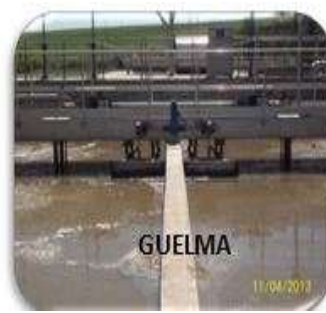
Figure 9 : Bassin Déshuileur des 2 station
