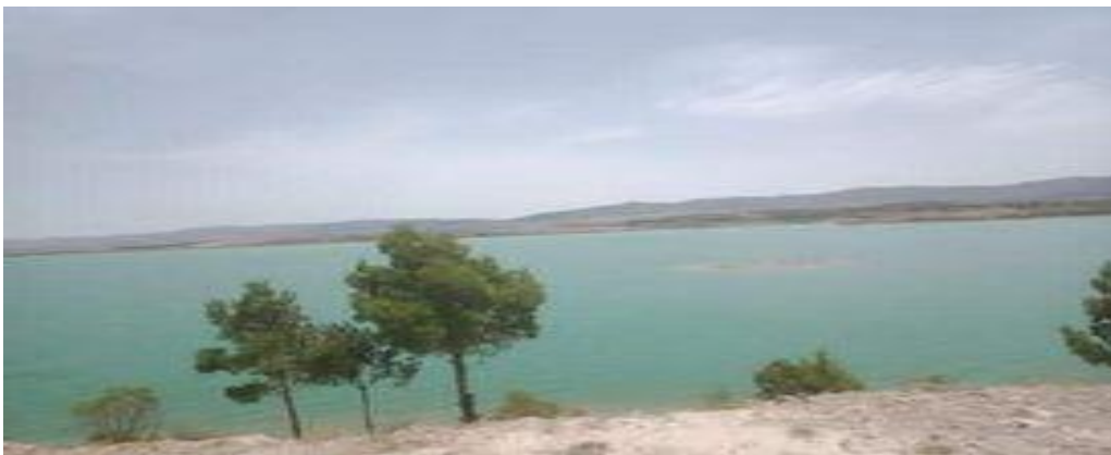
Barrage de Babar, wilaya de Khenchela
