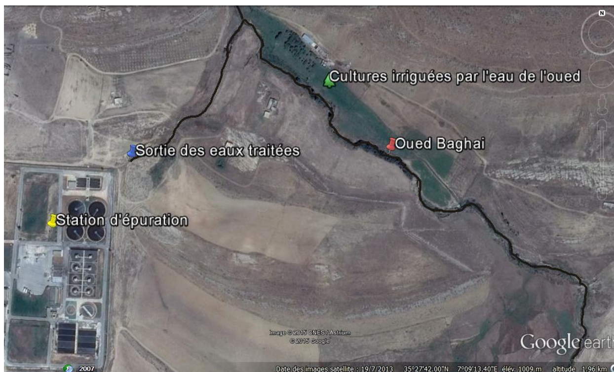
Photographie 01: Vue générale de la station d'épuration de la ville de Khenchela, Oued Baghai.
