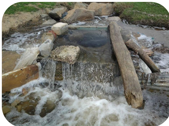
Photographie 02 : Point de sortie des eaux usées traitées.
