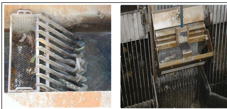
Figure 5. Dégrilleur à nettoyage manuel et dégrilleur à nettoyage automatique en entrée de station d'épuration (wikydro,2023)
