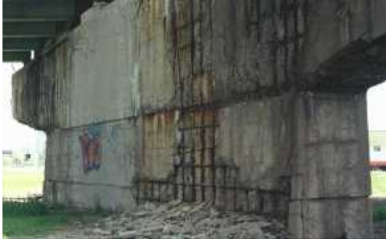
Figure II -18 : Agression du béton par activité des chlorures. [2]
