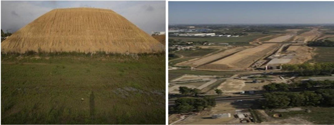
Figure 1. 2 : Exemples de Remblai
