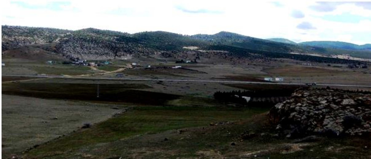
Figure 4.16 : Vue générale vers le sud au PK 15+800
