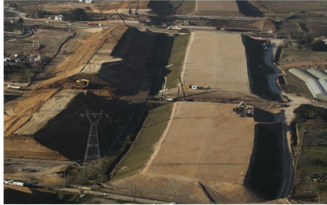
Figure 1.3 : Remblai de grande hauteur
