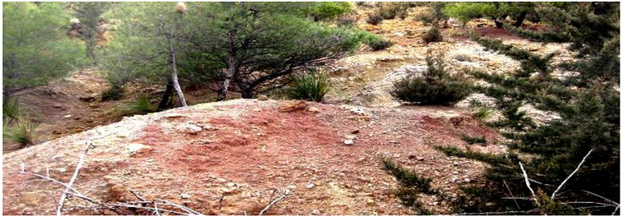
Figure 4.29 : Côté sud au PK39+800. Détail des argiles et cargneules du Trias
