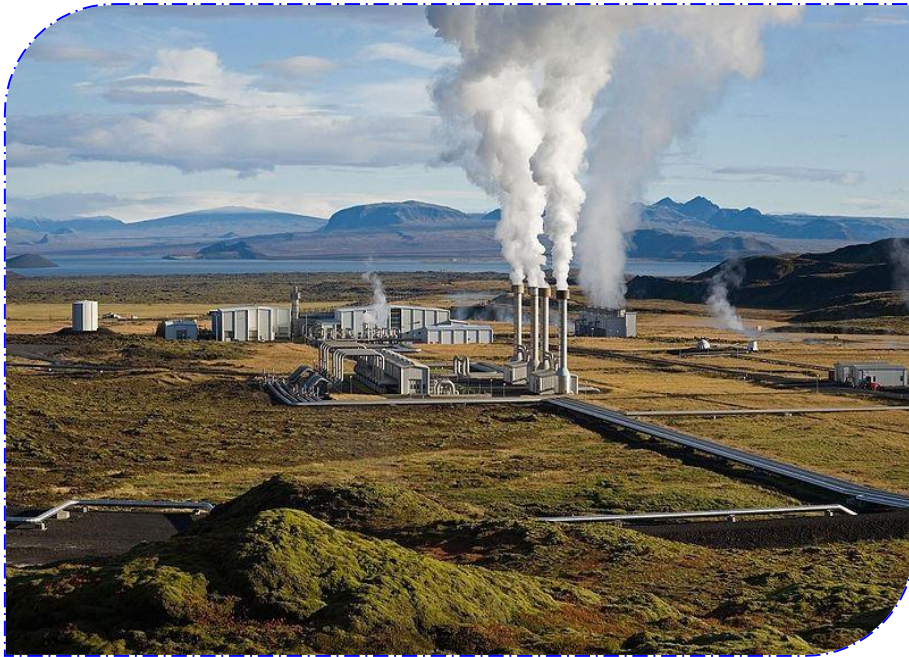
Figure I-7 : Centrale géothermique de Nesjavellir en Islande pour la production électrique.
