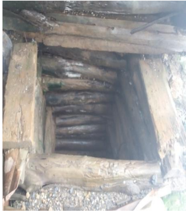
Figure II-4 : Cheminée servant de passage du personnel, reliant les deux niveaux d'exploitation 1690m et 1730m, filon n°4
