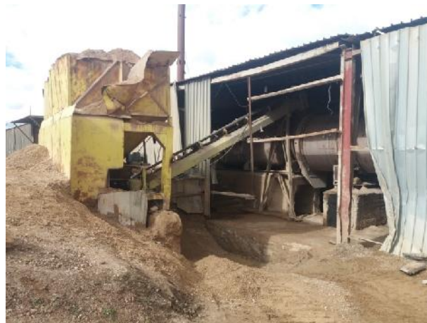
Figure II-15 : Station de séchage et broyage
