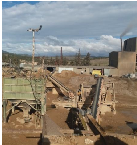
Figure II-11: Vue générale de la station du traitement actuel d'Ain Mimoun
