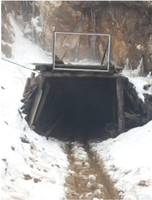
Figure II-3 : Embouchure de la galerie niveau 1730m, filon n°4
