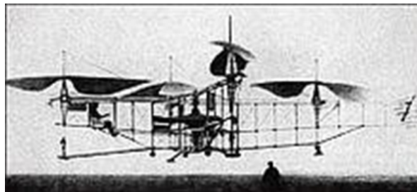
Figure 1.3: Appareille no2 d'Oehmichen
