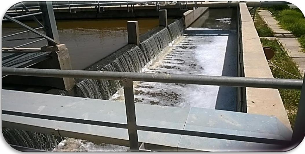
Figure 26 : Le Bassin de dégazage
