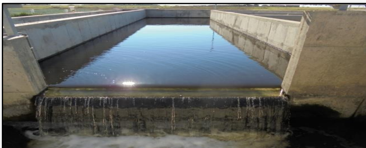
Figure 28 : Le bassin de chloration (la sortie des eaux épurées)
