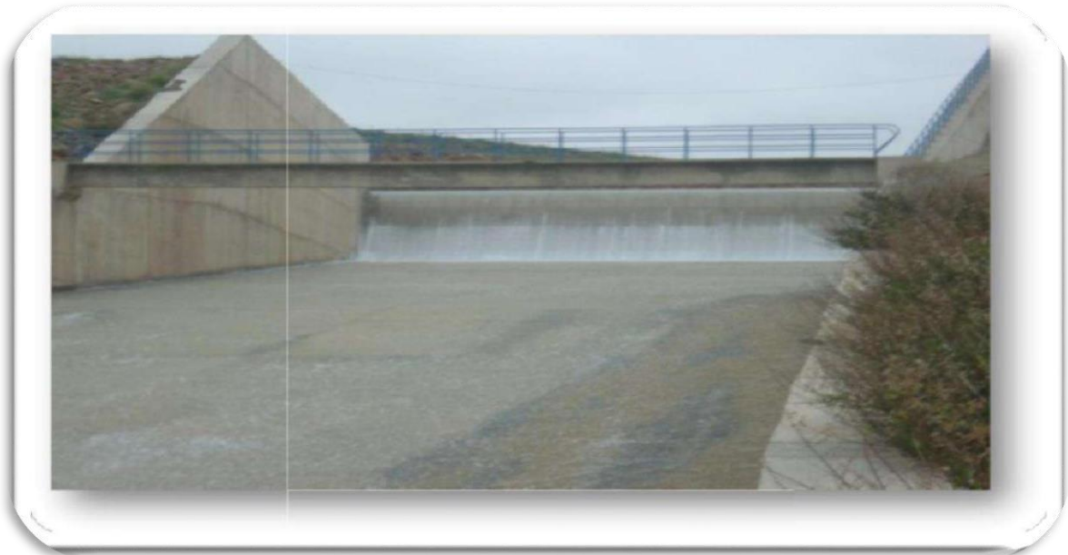
Figure 09: évacuateur de crue (déversoir)
