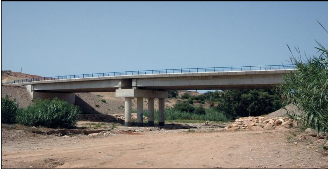
Figure 4. Pont à poutres à travées indépendantes en béton armé
