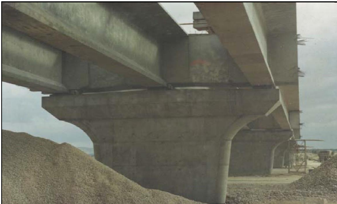
Figure 4. Pont à poutres à travées indépendantes en béton armé
