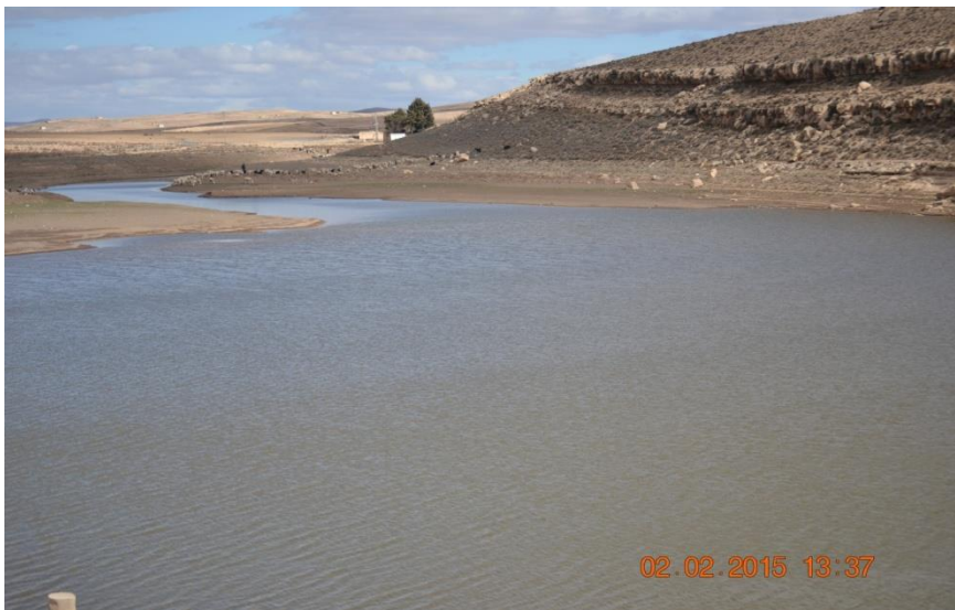
Photo N°08 : Retenue collinaire OUANGHAL (source CFK.2015).
