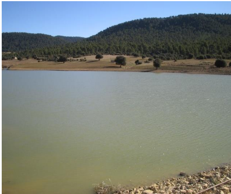
Photo N°03 : Retenue collinaire Touaguet (source CFK.2019)
