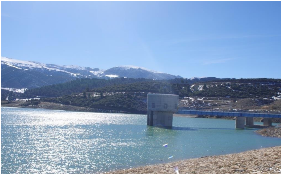
Photo N°06 : Barrage de Tagharist (source CFK.2015).
