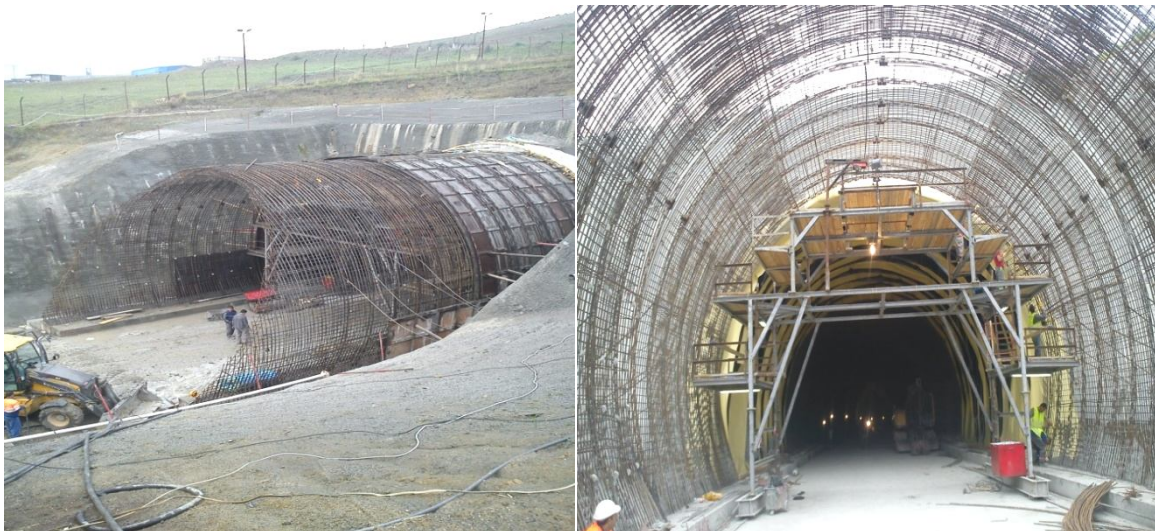
Figure. IV.19: Réalisation de pré-voûtes par pré-découpage mécanique
