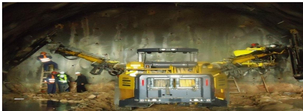
Figure.III.10: Chargement des trous par l'explosifs
