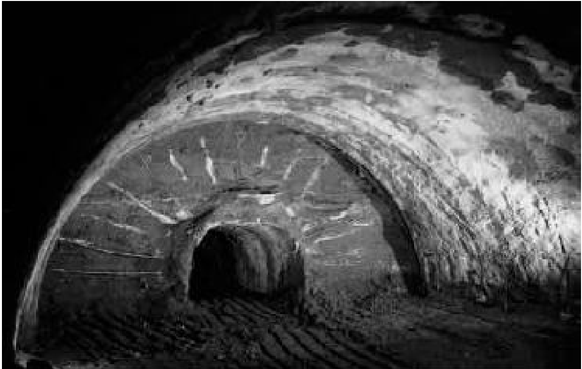
Figure V.1: Une galerie de reconnaissance [8].
