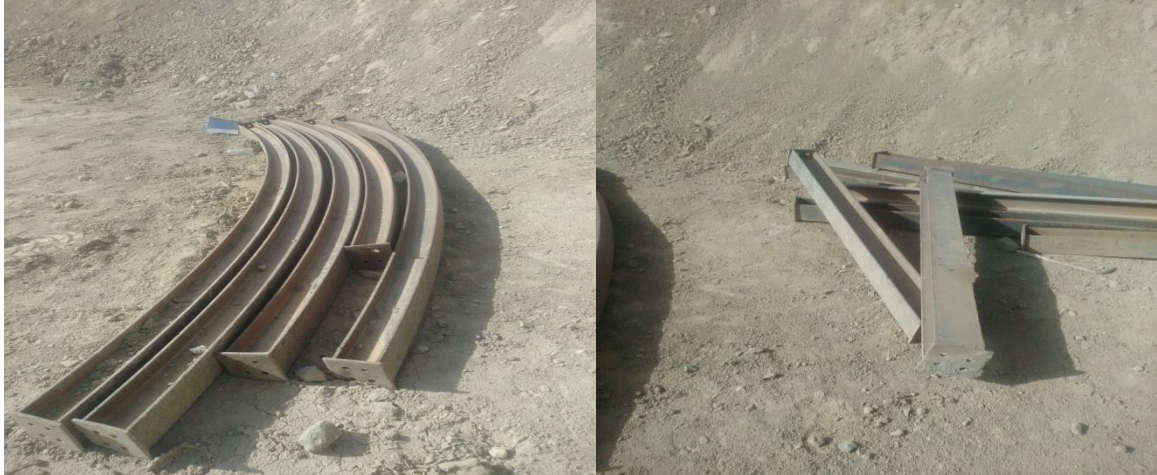
Figure IV.2: les pièces des cintres.
