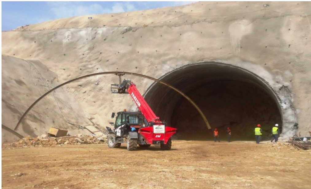
Figure IV.8: Assemblage du cintre HEB 140
