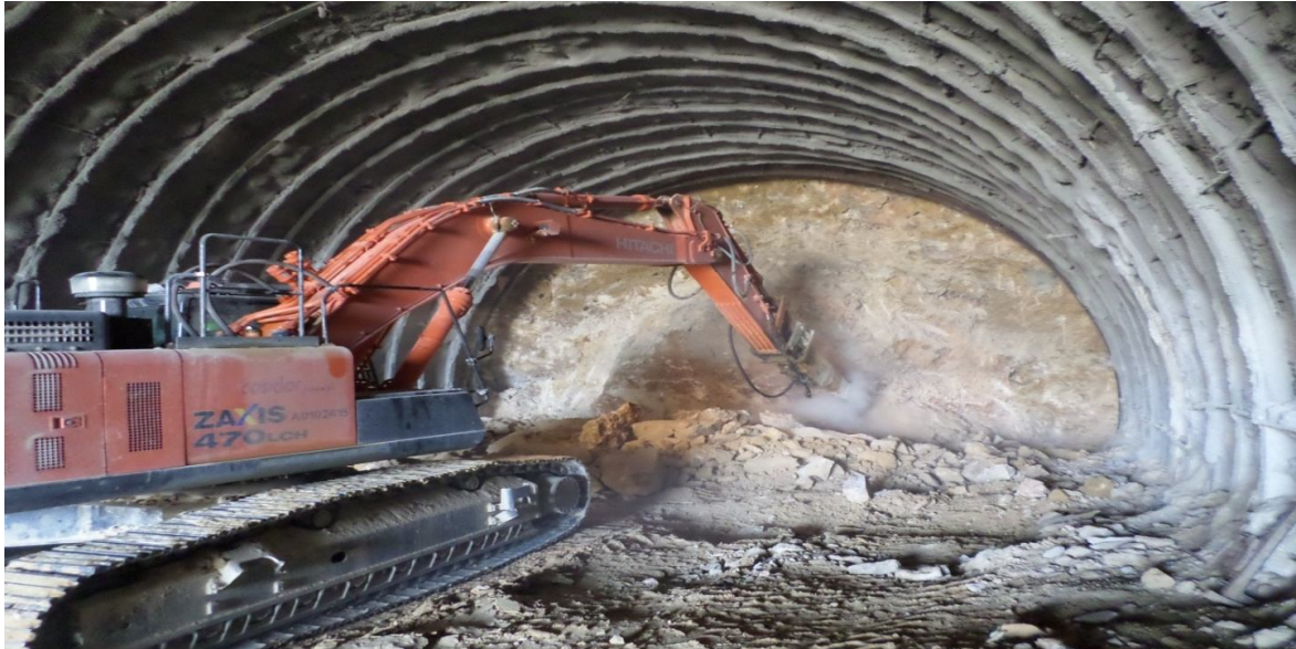
Figure III.18 : Creusement du tunnel par moyen mécanique
