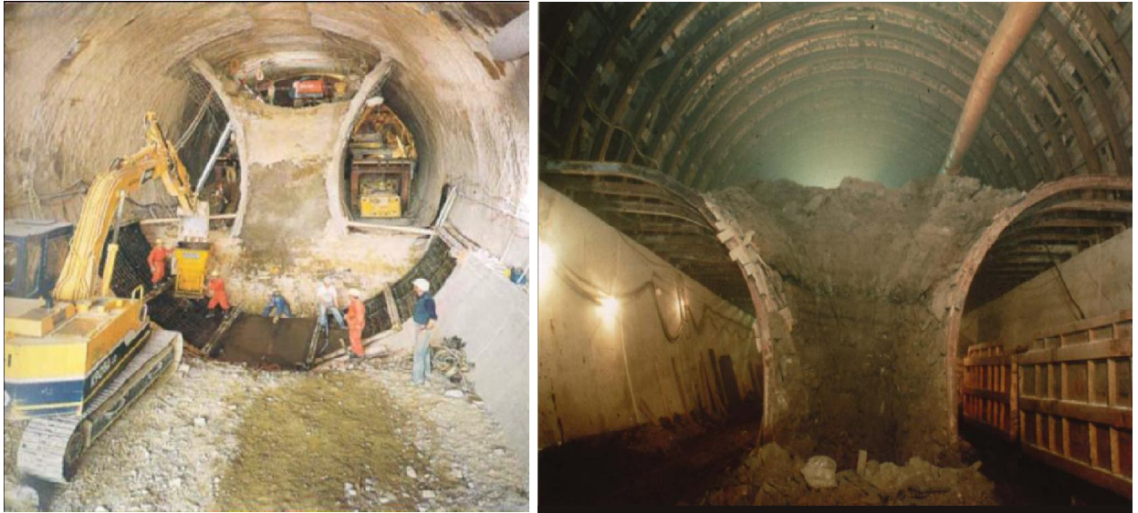
Figure III.6: image montre le creusement en section divisée
