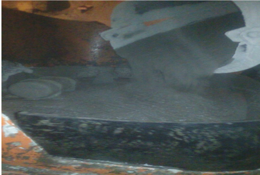
Figure IV.26: Béton projeté
