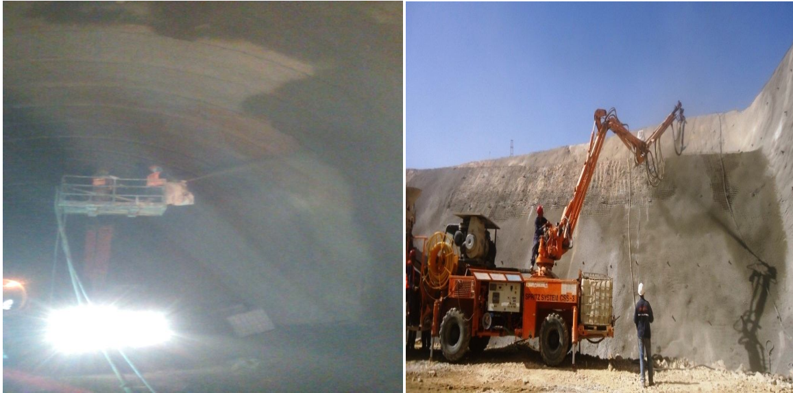
Figure IV.27: Mise en œuvre d'un béton projeté
