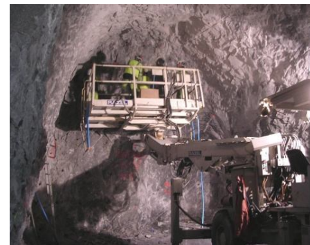
Figure III.13: Le chargement de la volée
