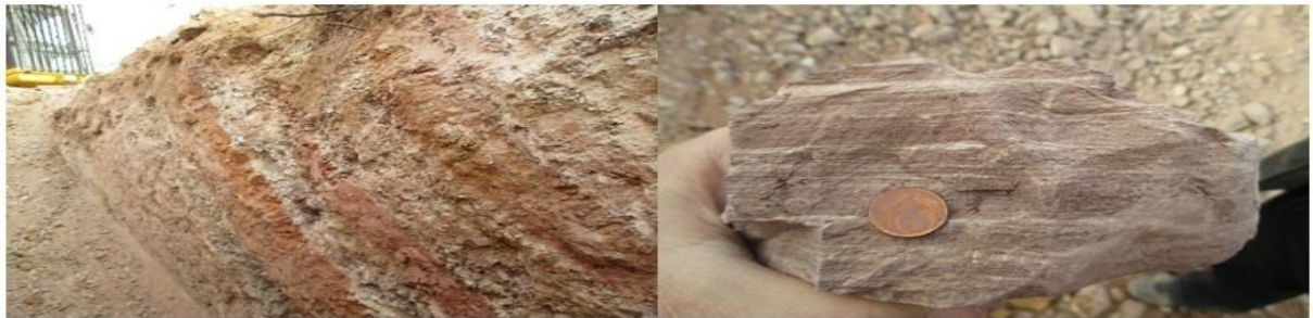
Figure V.7: Puits de reconnaissance exécuté dans l'unité Ct, dans la partie central du tunnel et détail d'un bloc de grès fin.
