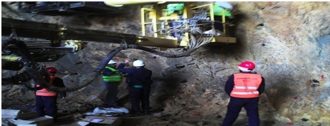
Figure.III.9: Creusement du tunnel en mine par explosifs
