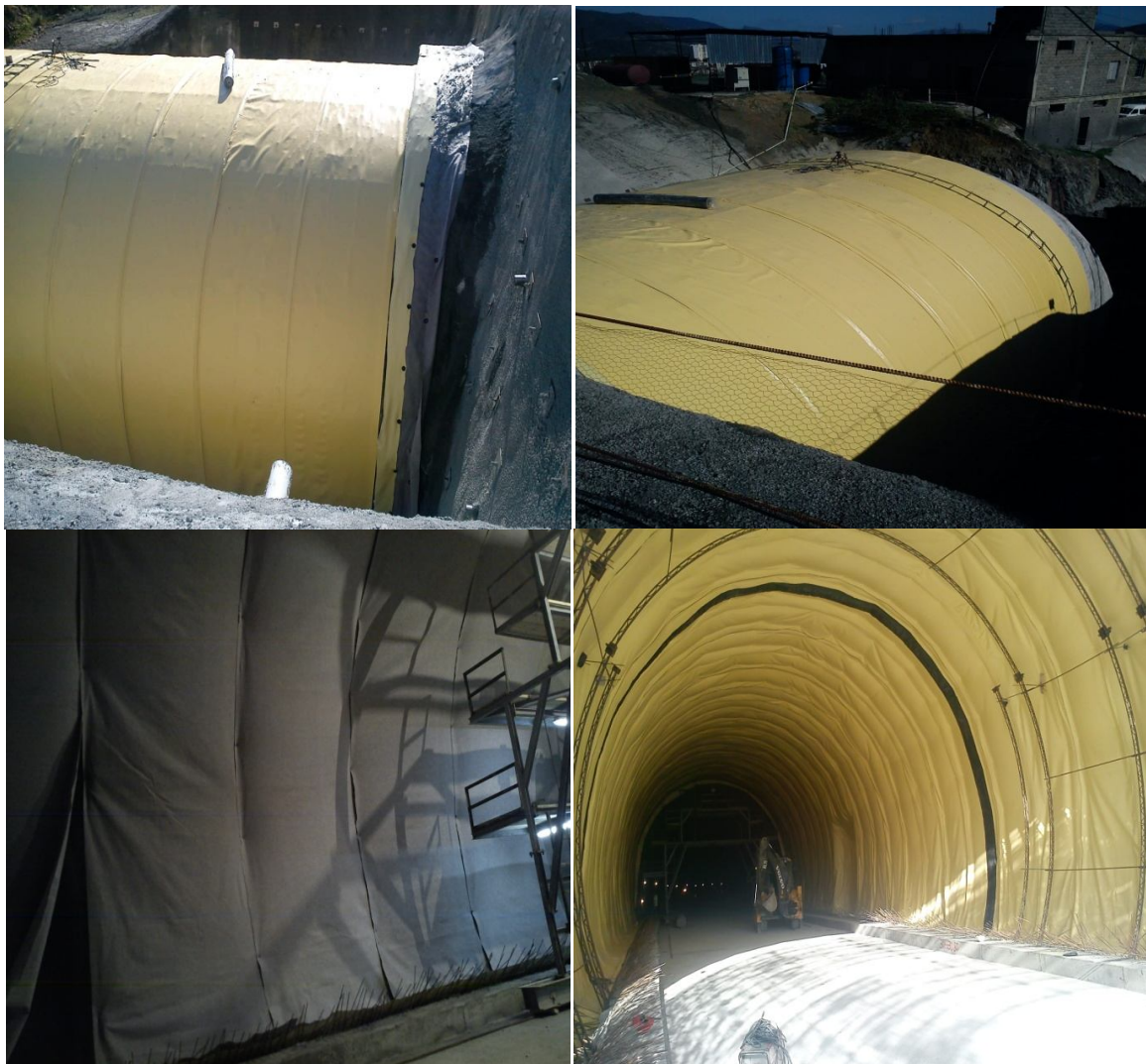
Figure IV.31: Etanchéité et système de drainage d'un tunnel.
