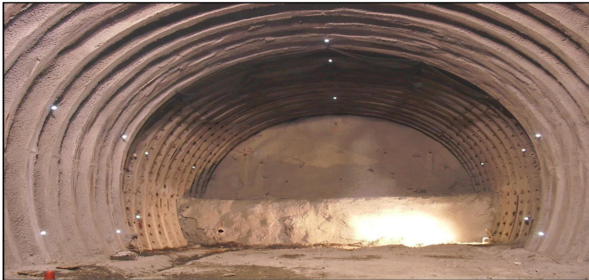
Figure IV.3: soutènement par cintre
