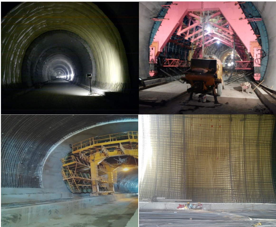
Figure IV.30: Revêtement du tunnel T2
