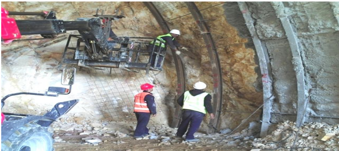
Figure IV.11: Mise en place des cintres
