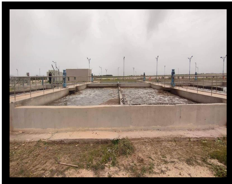
Figure 12 : La Station d'épuration de la commune de Kais
