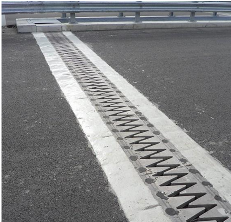
Figure 8.8 Joint de chaussée de type Wd
