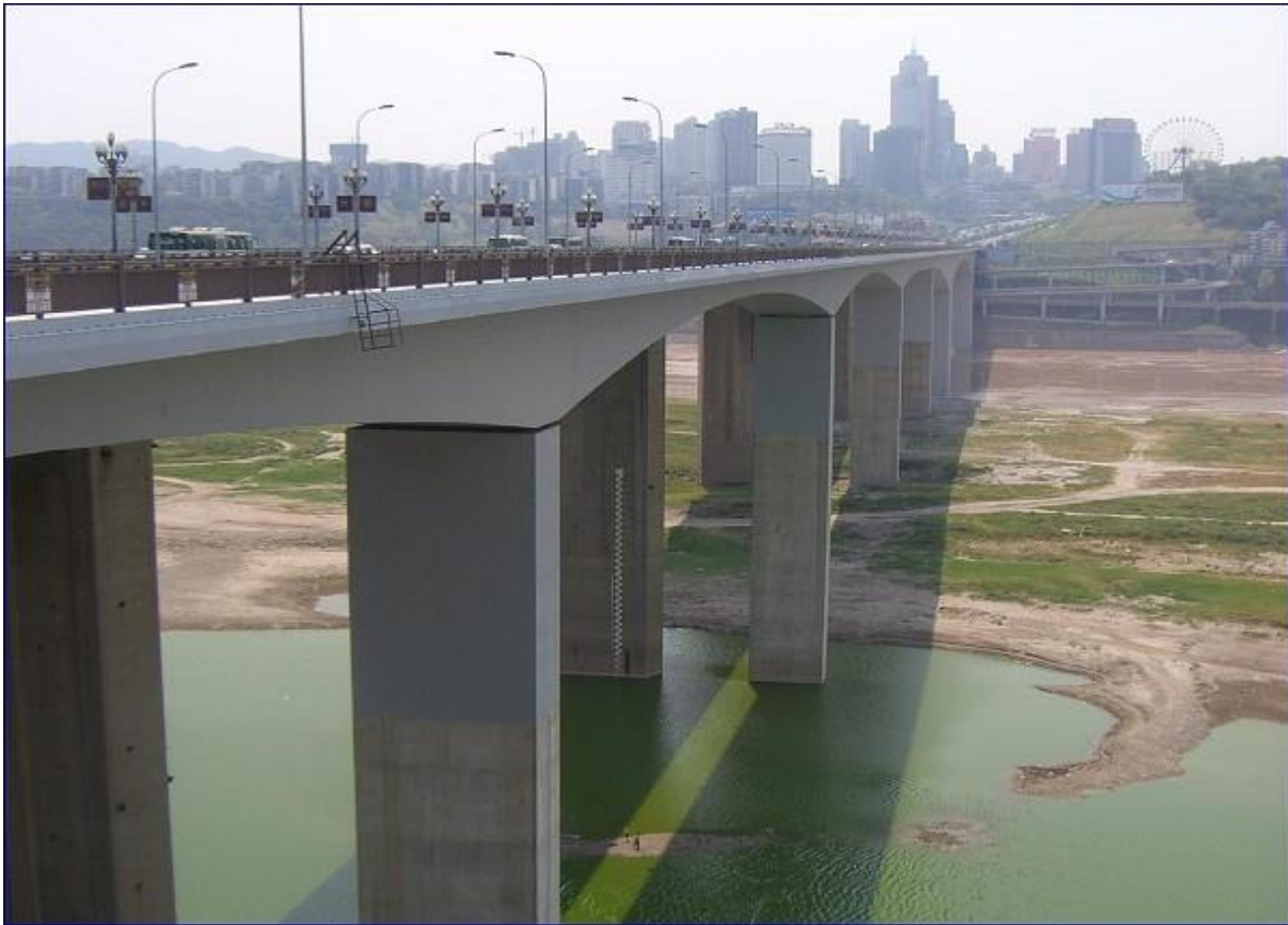
Figure 1.11 : Pont en béton précontraint (Shibanpo, Chine).
