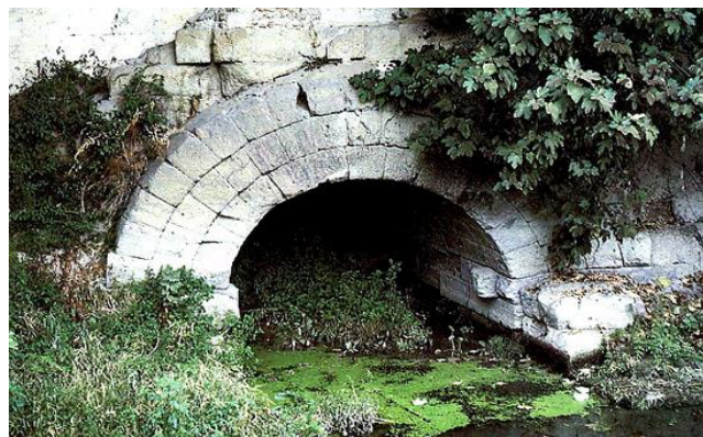
Figure 1.3 : Pont de Cloaca Maxima.
