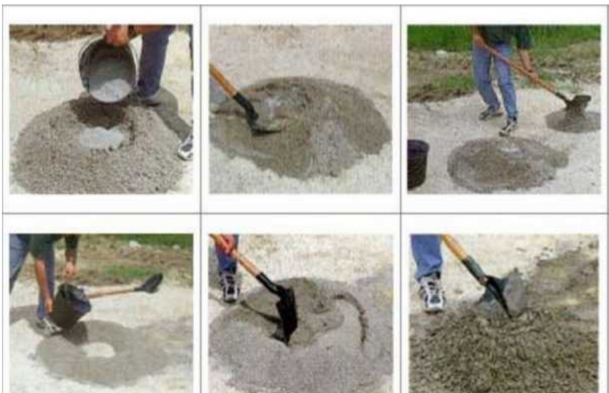
Figure I.15 : Préparation manuelle du mortier
