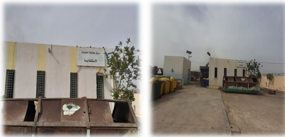
Figure 19 : Centre de traitement des déchets hospitaliers de Baghai.
