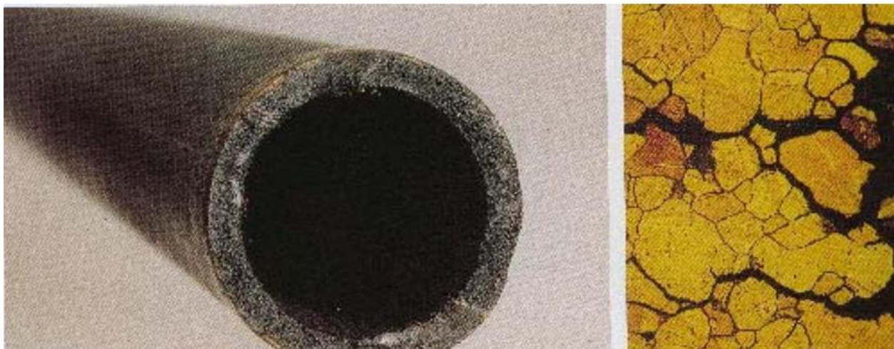
Figure I-8 : Corrosion au niveau des joints de grains d'une structure métallique.
