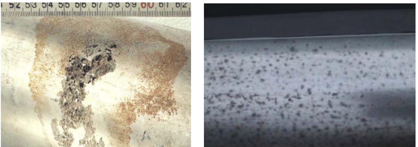
Figure I-6-b : Corrosion par piqûre de l'aluminium.
