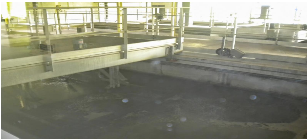
Figure I.4 : Schéma d'un déshuileur-dégraisseur.
