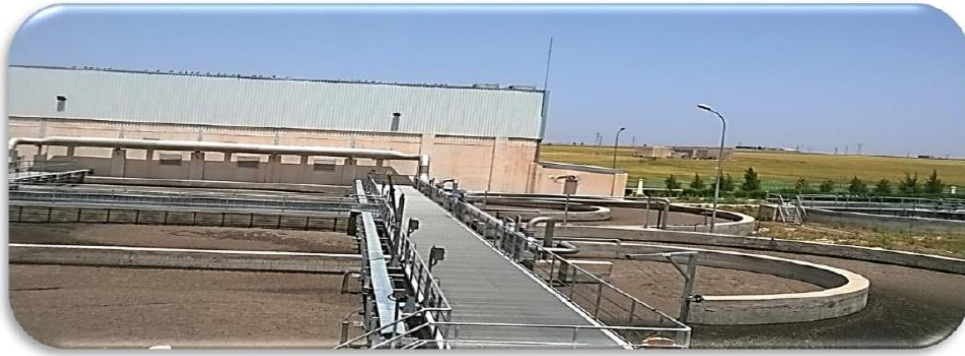
Figure II.16 : Le digesteur des boues épaissies
