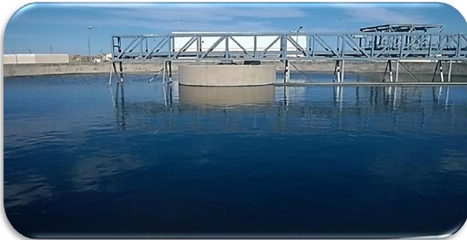
Figure II.13 : Le Décanteur
