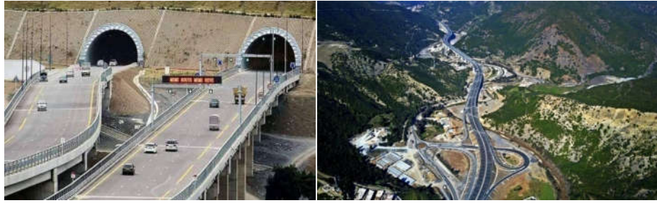
الشكل رقم (05): الطريق السيار شمال - جنوب
