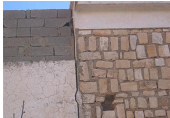
Photo I.30-31: Ouverture du joint de dilatation
