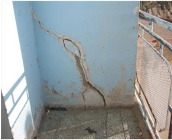
Photo I.28-29: Fissures inclinées au niveau des murs porteurs
