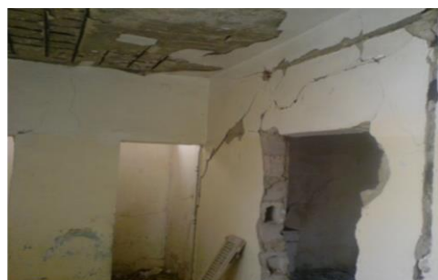
Photo I.25et26: Fissures verticales, horizontales et obliques, dislocation, affaissement au niveau des murs
