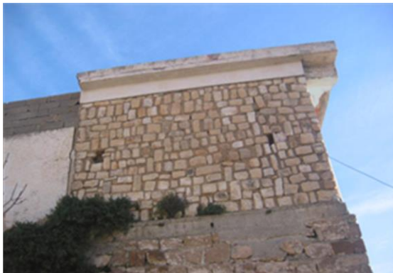
Photo I.30-31: Ouverture du joint de dilatation
