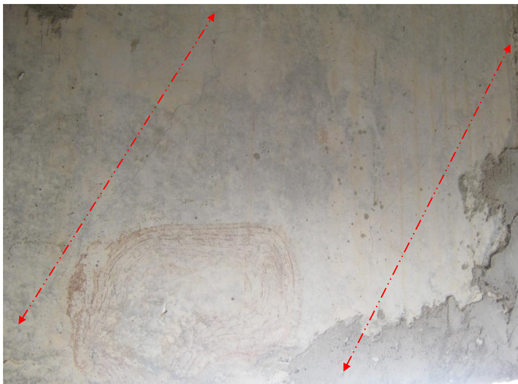
Photo I.77 Vue de près d'une fissure.
