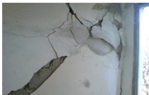
Photo I.25et26: Fissures verticales, horizontales et obliques, dislocation, affaissement au niveau des murs
