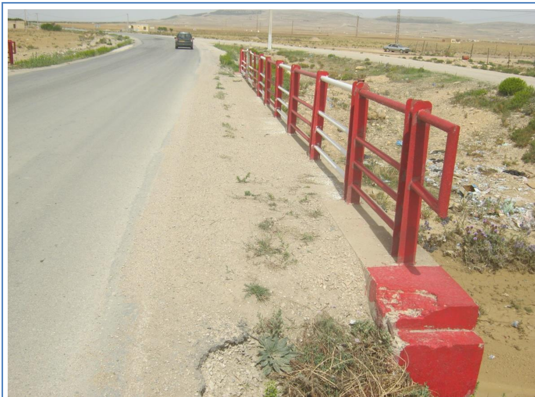
Photo I.71 Garde-corps côté aval.
