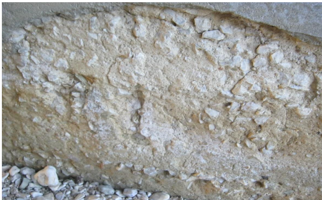
Photo I.87 Face latérale piédroit.
