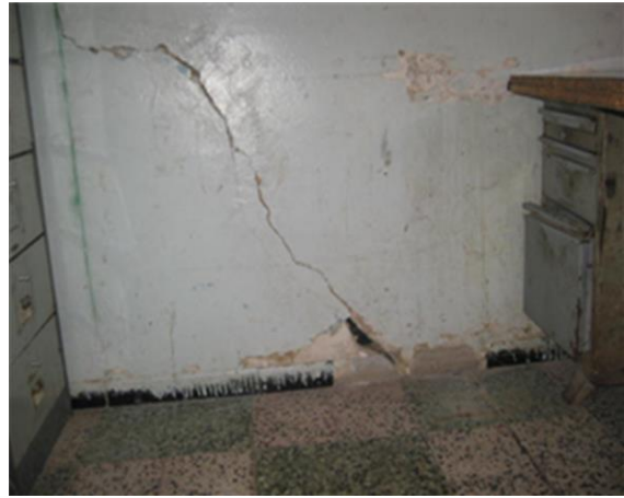
Photo I.28-29: Fissures inclinées au niveau des murs porteurs
