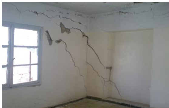
Photo I.20-21: Fissures verticales, horizontales et obliques au niveau des murs & fissures et déformation de la plateforme.
