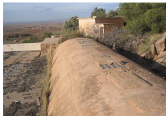
Photo I.36-37: Fissures au niveau des voûtes
