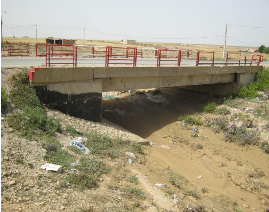
Photo I.66 : Ouvrage d'art sur oued aïn touila RN88 PK117+000
