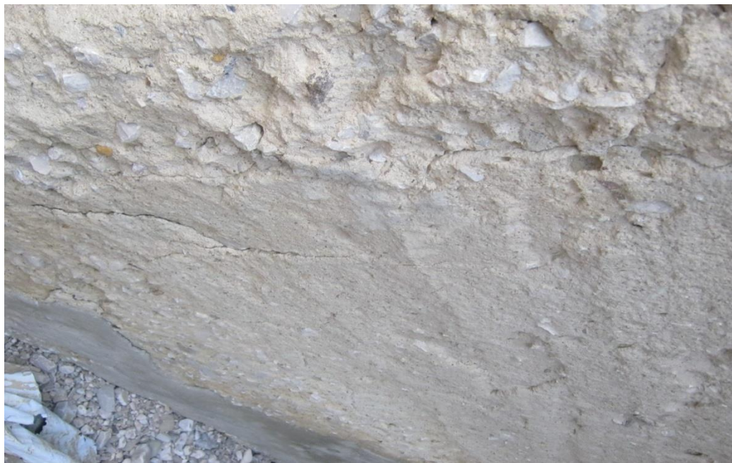
Photo I.86 Face latérale piédroit.
