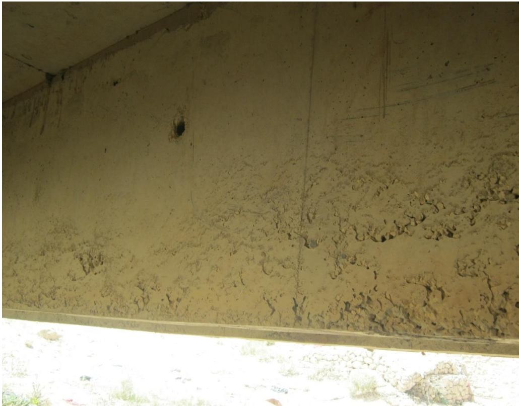
Photo I.75 Ségrégations et ragréages généralisés.
