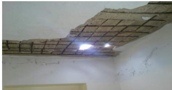
Photo I.18-19: Corrosion et déformation des armatures et effondrement d'une partie du plancher terrasse.
