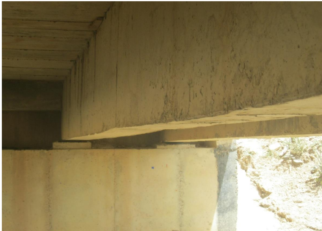
Photo I.73 Parement du talon de la poutre.
