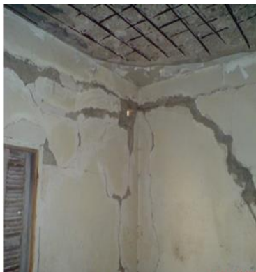
Photo I.23et24: Corrosion et déformation des armatures, cloquage et décollement des enduits des planchers terrasses.
