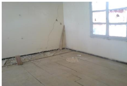
Photo I.20-21: Fissures verticales, horizontales et obliques au niveau des murs & fissures et déformation de la plateforme.
