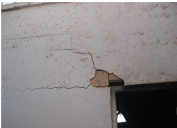
Photo I.32-33: Fissures au niveau des portes
