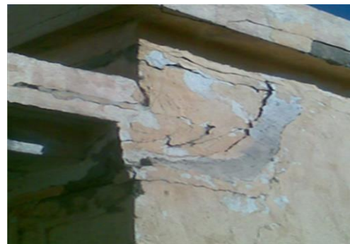
Photo I.44: dislocation de chaînage de passage couvert en tête du fait du tassement
