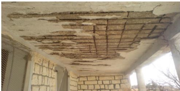
Photo I.18-19: Corrosion et déformation des armatures et effondrement d'une partie du plancher terrasse.
