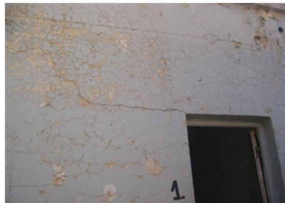
Photo I.32-33: Fissures au niveau des portes
