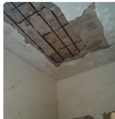
Photo I.23et24: Corrosion et déformation des armatures, cloquage et décollement des enduits des planchers terrasses.
