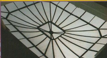
Abri pour mosquée
