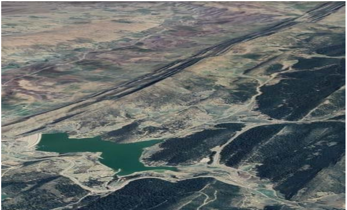
Figure 9. Situation géographique du barrage de Tagharist(Google Earth).
