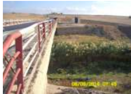
Figure 15. Station 2 A l'amont du barrage de Charef (Oued Sedrata).
