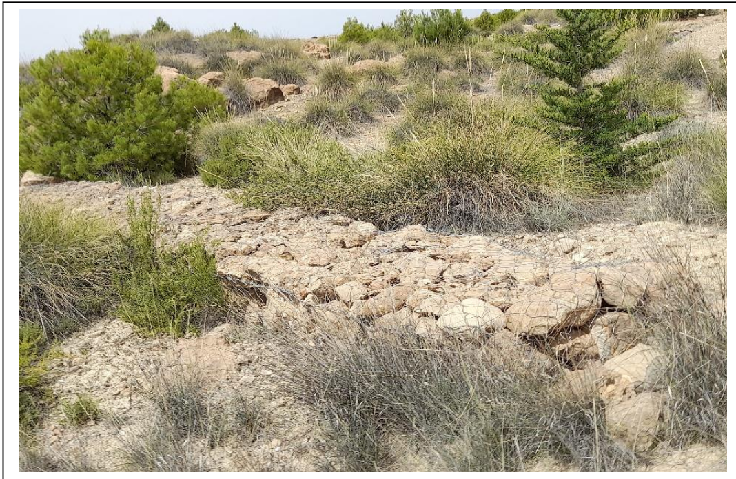
Figure 20 : Les seuils en gabion (Hoggas et Boughougal, 2021)
