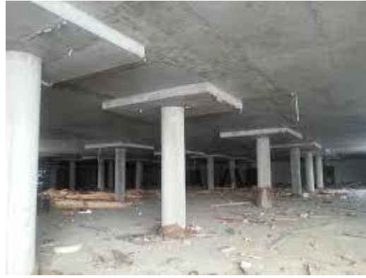
Figure I.2 : Plancher à dalle pleine.
