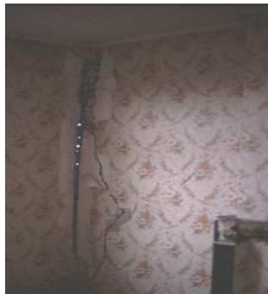
Figure II.7: Liège, 1983. Effet de la faiblesse des diaphragmes (fissuration à l'angle des murs) ou de la faiblesse de leur connections aux murs (effondrement de façade).[2]
