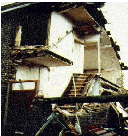
Figure II.7: Liège, 1983. Effet de la faiblesse des diaphragmes (fissuration à l'angle des murs) ou de la faiblesse de leur connections aux murs (effondrement de façade).[2]
