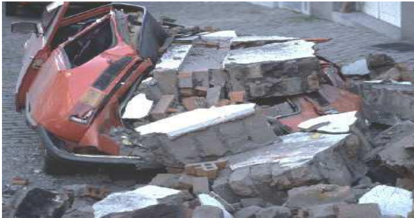
Figure II.14 : Chute de cheminée et destruction d'unevoiture (Renault R5, Liège, 1983).[2]
