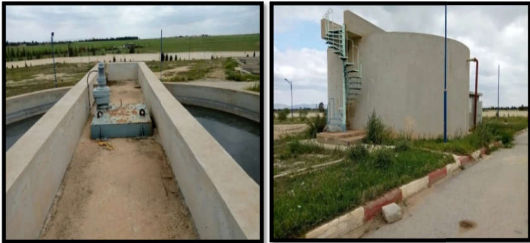
Fig.11: L'épaississeur de la STEP.
