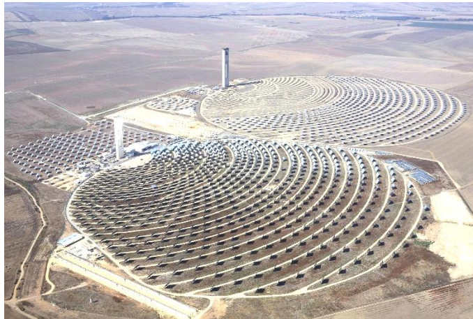
Figure 6 : Vue aérienne de la tour solaire PS10 de 100MW à Sanlúcar la Mayor. Espagne. (Reproduit de Concentration Solar Power - de la recherche à la mise en œuvre. C. Communautés européennes).
