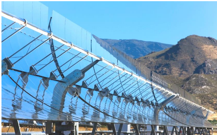
Figure 5 : Centrale à auge
