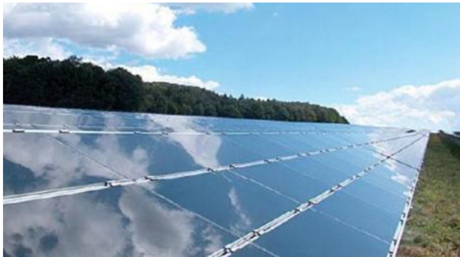
Figure I.12 : Modules verre-verre au Telluride de Cadmium, efficacité de 9 à 11%.
