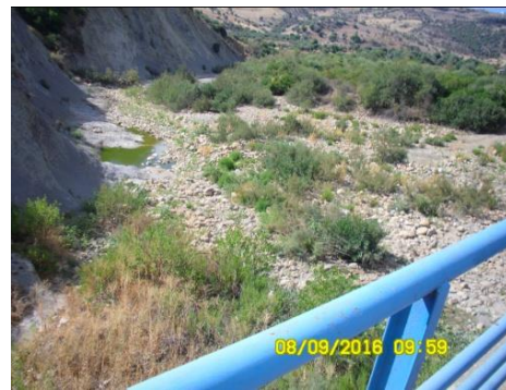
Figure 16. Station 4 : A l'amont du barrage de Bouhamdane.
