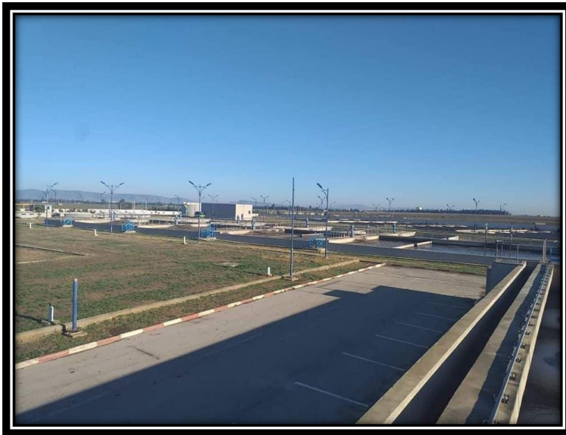
Figure 21 : La Station d'épuration de la commune de Kais
