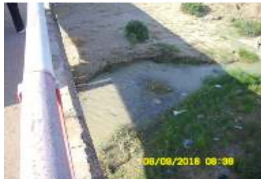
Figure 14. Station 3: A l'aval du Barrage de Charef. D'après( Allègue, 2017) .
