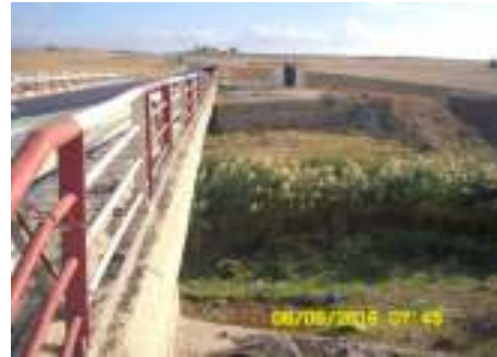
Figure 13. Station 2 A l'amont du barrage de Charef (Oued Sedrata).
