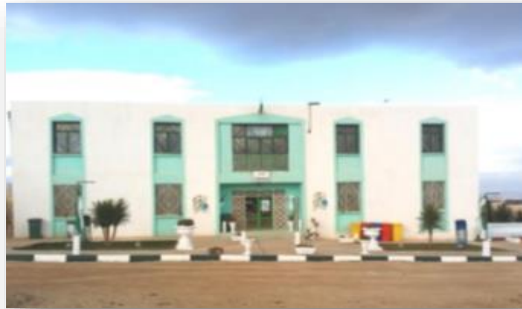
Figure 09 : Bloc administratif du centre d'enfouissement technique de Baghai (EPWG)
