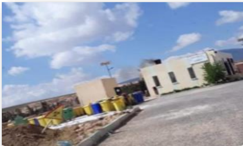
Figure 19 : Station de traitement des déchets hospitaliers de Baghai (EPWG)
