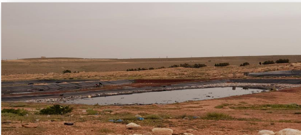
Figure 17 : Drainage de lixiviat vers les bassins de décantation
