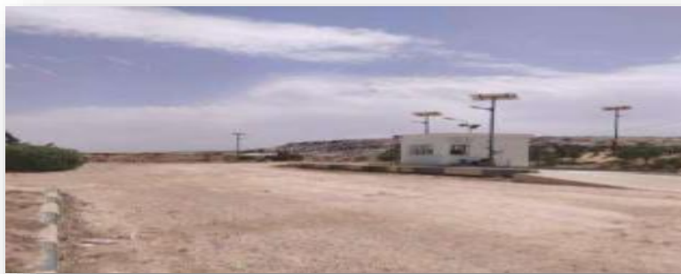
Figure 14 : Le poste de contrôle et le pont bascule du CET (EPWG)
