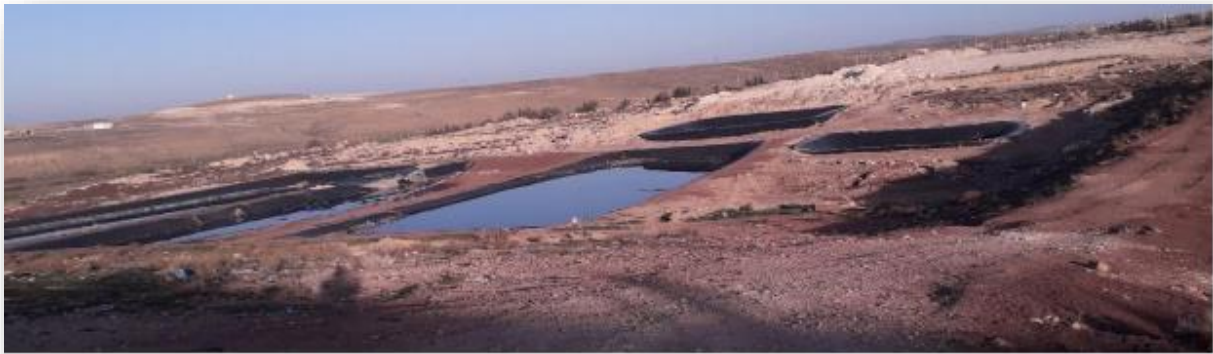
Figure 02 : Bassins de décantation de lixiviats
