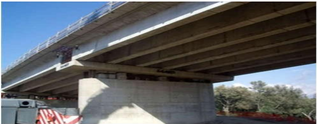
Figure 2 : Pont en béton armé
