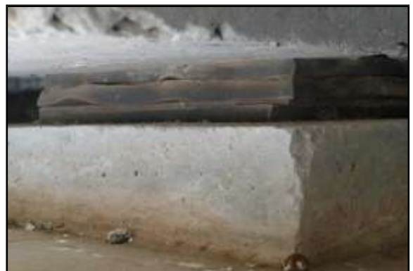
Figure 4.10 : Appareils d'appui en néoprène déformés
