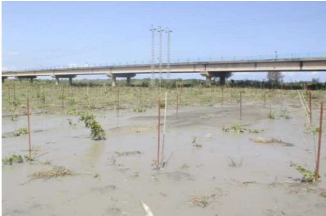
Figure 1.12 : Liquéfaction du sol au niveau de Oued Isser
