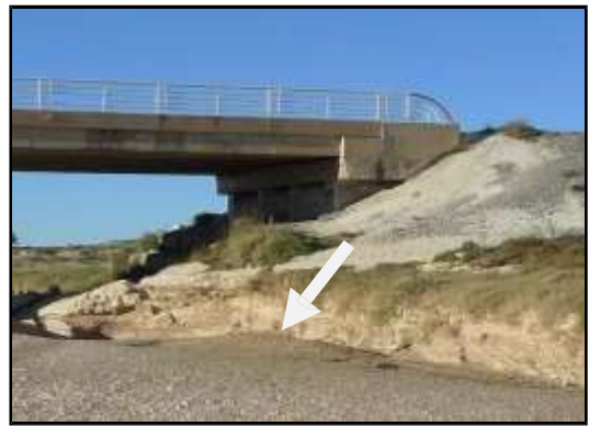
Figure 4.13 : Insuffisance de protection des remblais et des berges
