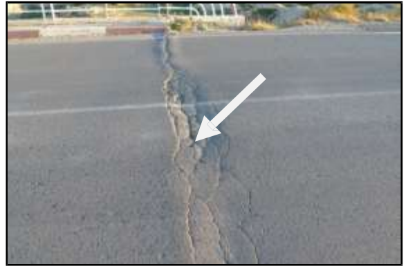
Figure 4.9 : Joints de chaussée entièrement fermés
