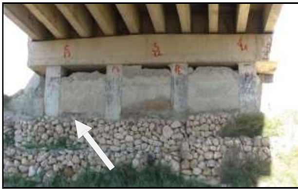
Figure 4.13 : Insuffisance de protection des remblais et des berges
