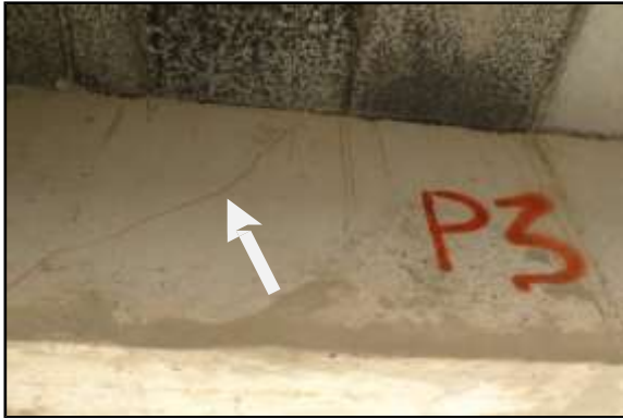
Figure 4.5 : Fissures inclinées
