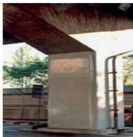
Figure 3.3 : Exemple de piles renforcées par chemisages métalliques
