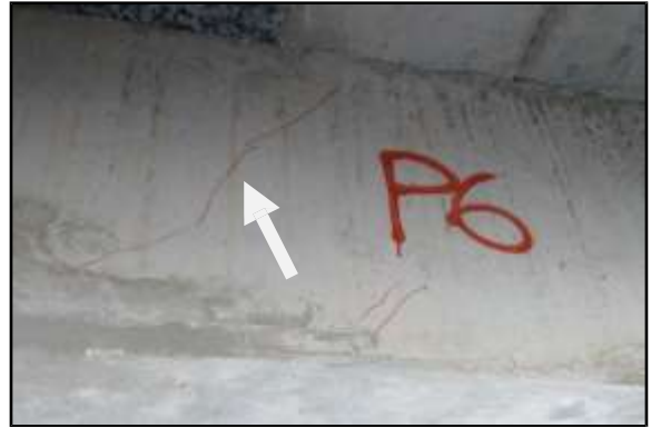
Figure 4.5 : Fissures inclinées
