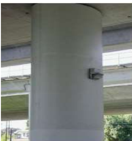
Figure 3.3 : Exemple de piles renforcées par chemisages métalliques
