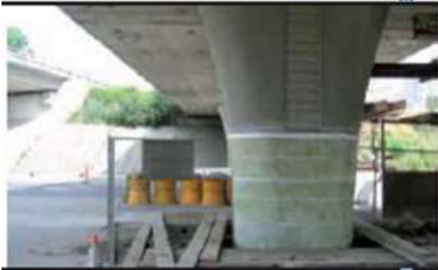
Figure 3.6 : Exemple de piles renforcées par matériau composite
