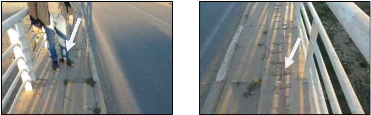
Figure 4.8 : Perte d'enrobage et Apparition des aciers
