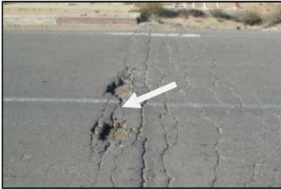
Figure 4.9 : Joints de chaussée entièrement fermés
