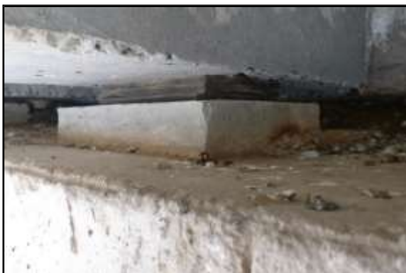
Figure 4.10 : Appareils d'appui en néoprène déformés
