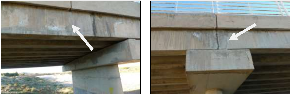
Figure 4.4 : Coulures noires Eclatement de l'enrobage
