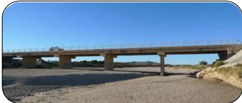
Figure 4.1 : pont à la Wilaya de Tebessa sur le CW02 au PK53+900
