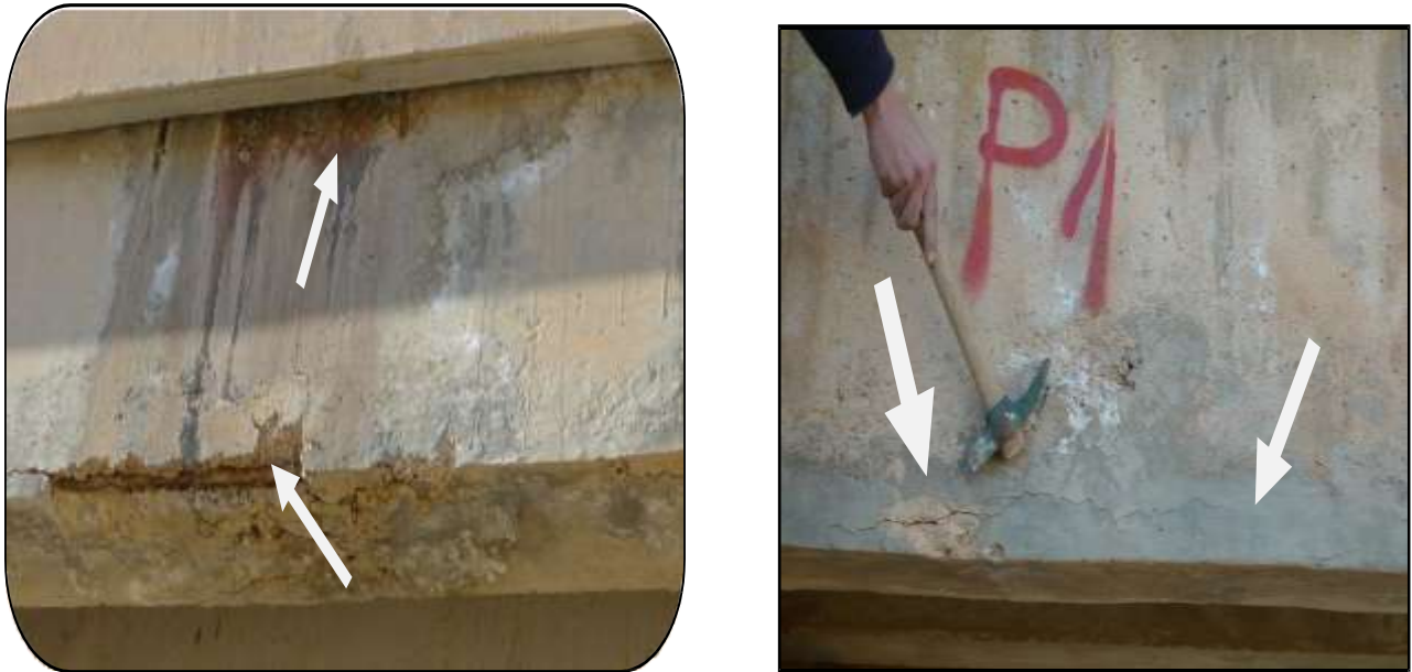
Figure 4.3 : Cassure au droit du talon et Perte d'enrobage
