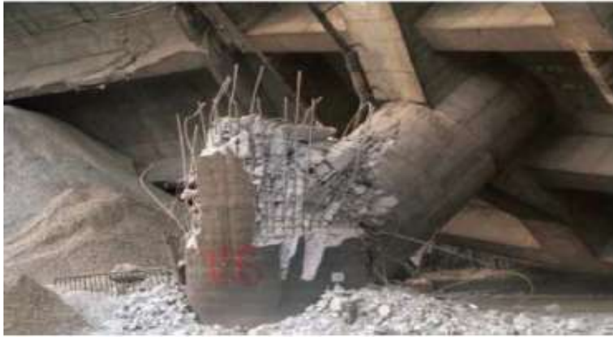
Figure 1.8 : Rupture des piles par cisaillement et effondrement du tablier (Kobe, 1995)
