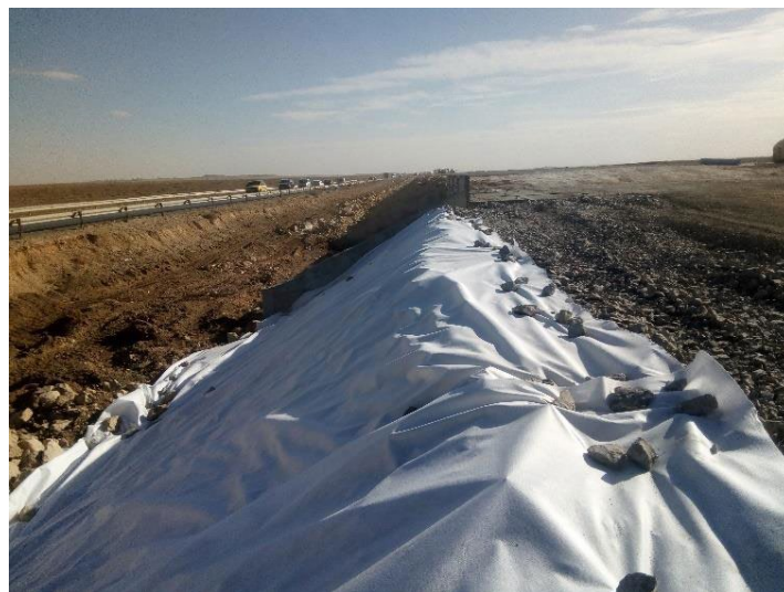
FigureVII.4. Montée du remblai et mise en œuvre du géotextile sous enrochement
