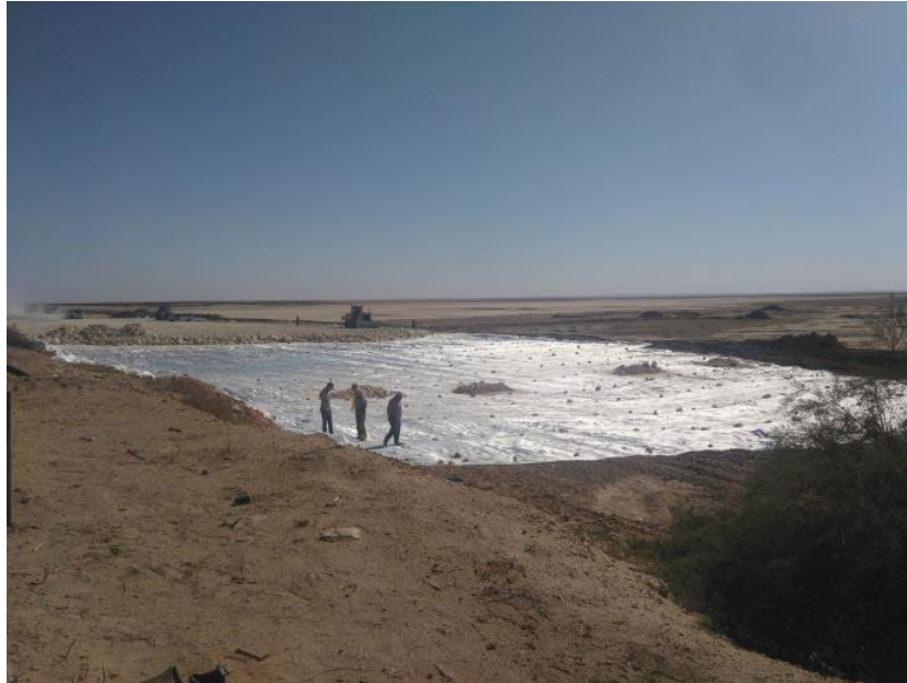
FigureVII.3. Mise en œuvre du géotextile sur la couche forme
