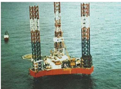
Figure I .29: Plateforme de forage CFEM T 2005 Autoélévatrice
