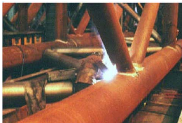
Figure I .53 : Soudage d'éléments tubulaires
