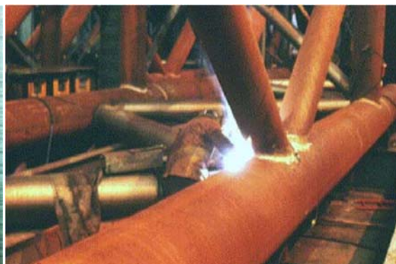
Figure I .30: Soudage des éléments tubulaires d'une plate forme offshore
