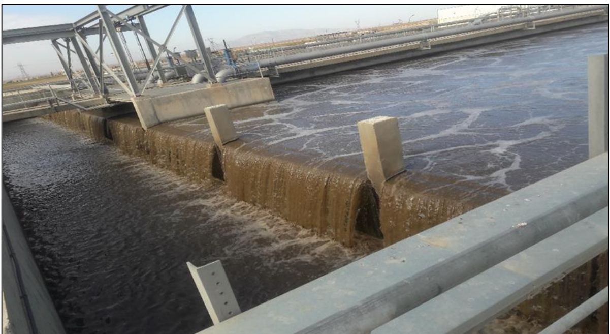
Figure 23. Bassin de dégazage
