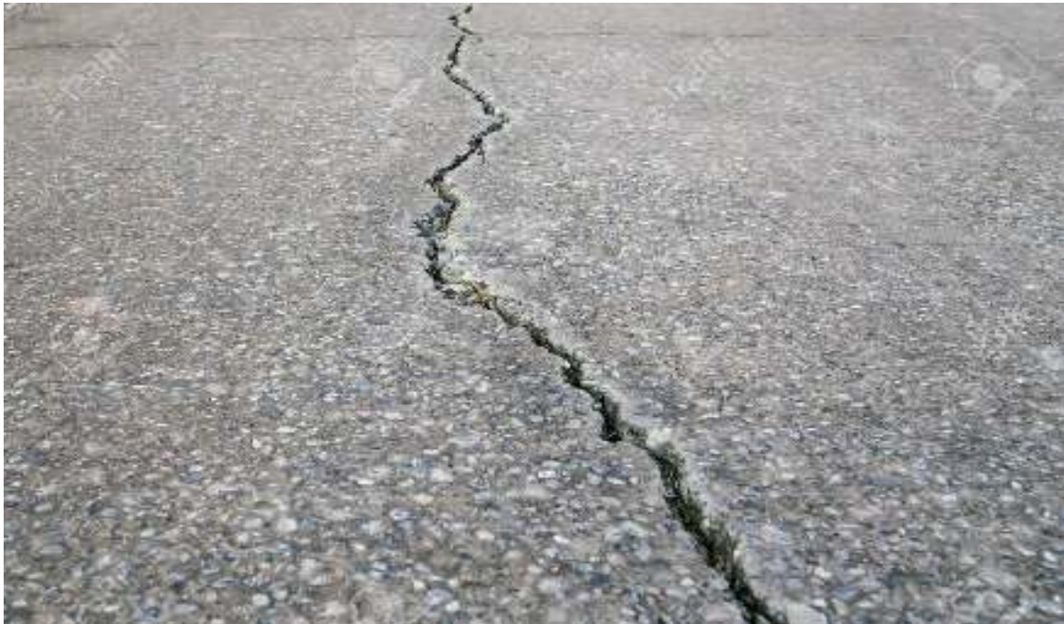
Figure XXII: Fissuration longitudinal
