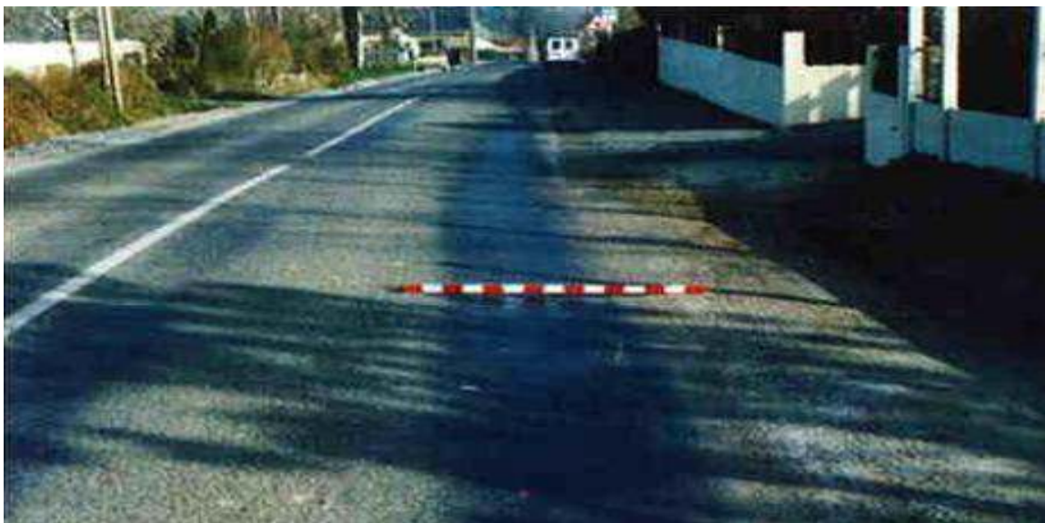
Figure XXVI: Glaçage ou indentation
