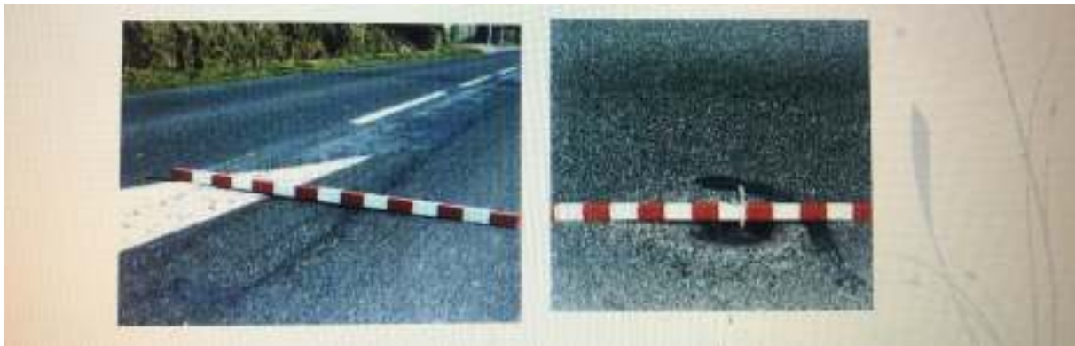
Figure XX: L'affaissement hors rive (flashe)
