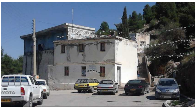
Fig. 16: Vaporium Hammam Elknif ; face Sud.
