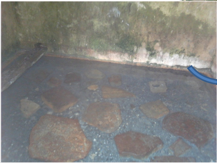
Fig. 22 : Photo Hammam Djaarir vue interne
