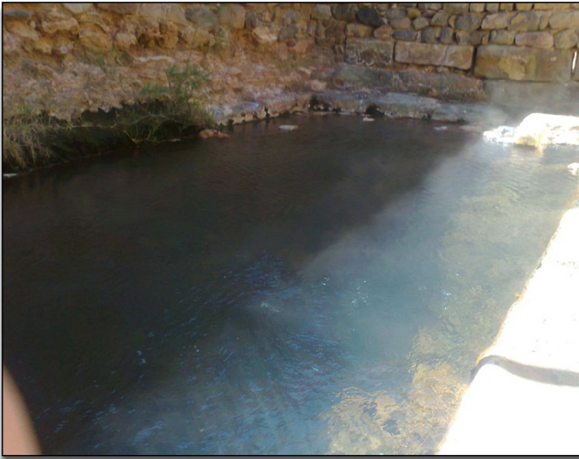
Fig. 12: Hammam Essalhin ; Griffon 01 vue interne ; bassin de captage.
