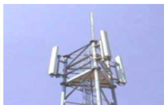
FIGURE II.6 – Antenne sectorisée.
