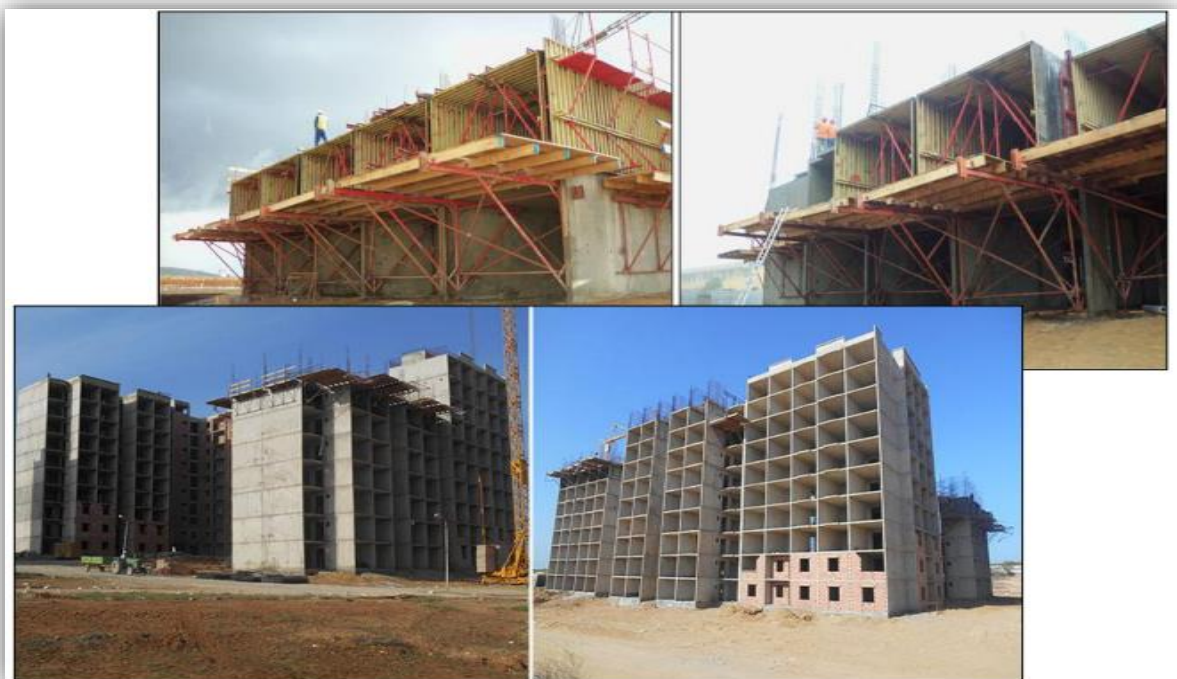
Figure I.22. Technique coffrage tunnel sur chantier.
