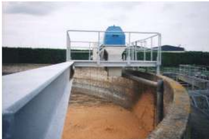
Figure II.3 : Épaississement des boues
