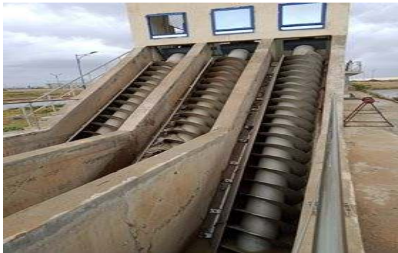
Figure I.3 : poste de relevage – STEP de kais
