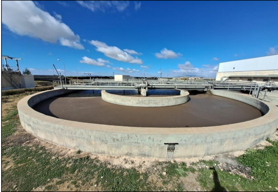
Figure 21. L'épaississeur secondaire (2024)
