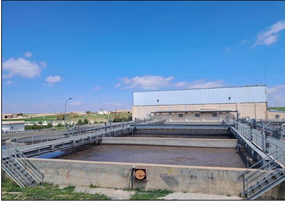
Figure 20. Le digesteur aérobie (2024)
