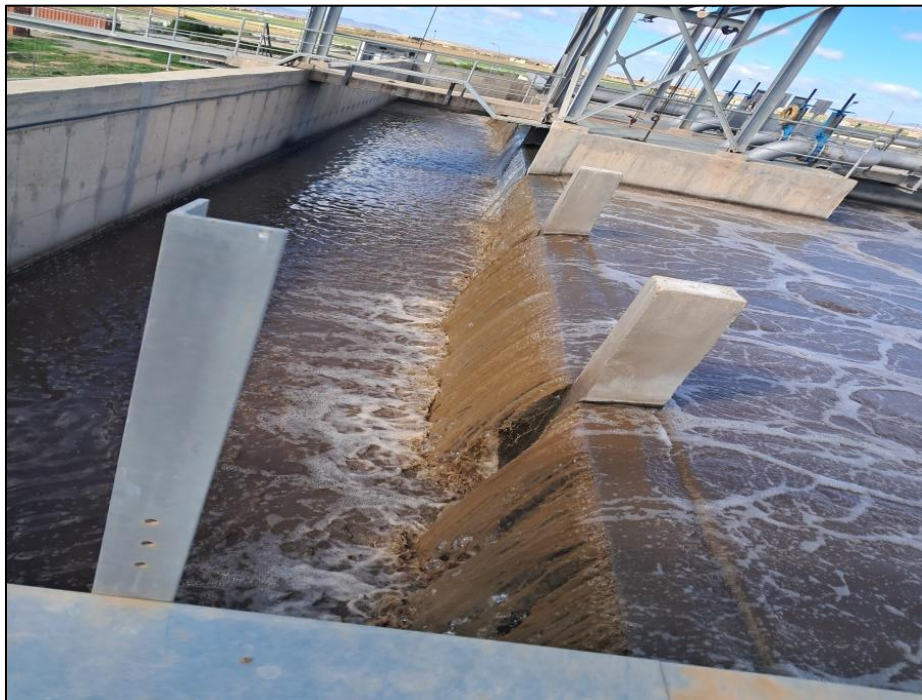
Figure 16. Bassin de dégazage (2024)
